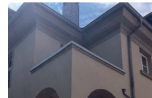
176 Sanierung einer Villa am Staden 2014 Bismarckstraße 75, 66121 Saarbrücken Architekten braun & eyer architekten, Christian F. Braun, Patric Eyer, Saarbrücken Geführte Besichtigungen Sa 12.30 - 15 Uhr Foto Christian F. Braun
